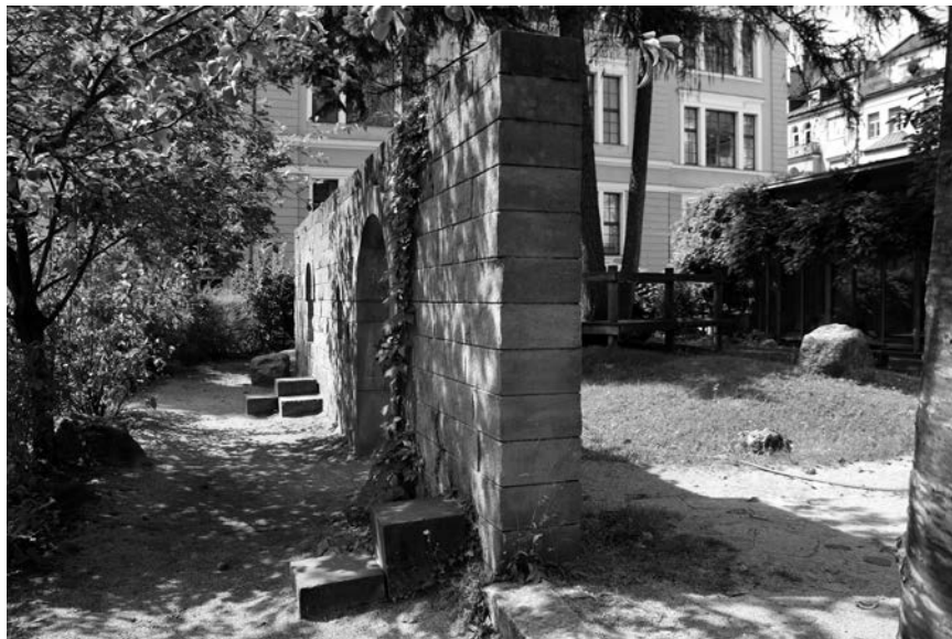
Fig. 2 - Muro costruito nel giardino di un Kindergarten
