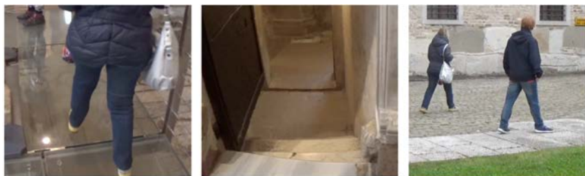
Figura 1. Barriere fisiche all'accessibilità. Tali fotogrammi tratti dall'analisi retrospettiva dei video girati durante la visita descrivono gli ostacoli fisici che hanno impedito la piena interazione con gli spazi dell'area archeologica. I primi due fotogrammi, partendo da sinistra, descrivono degli esempi di barriere architettoniche (fessure nella passerella di vetro; assenza di passamano nelle scale) - categoria A; l'ultima foto a destra rappresenta un esempio di barriera percettiva (assenza di indicazioni chiare che favoriscano l'orientamento negli spazi) - categoria B.
